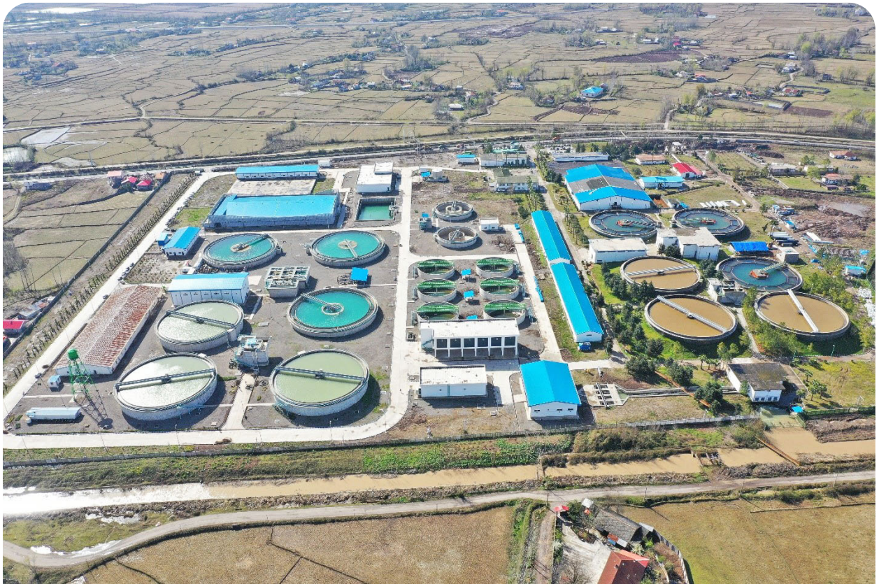
▲ تصفیه‌خانه آب گیلان (به ظرفیت ۶۰۰۰ لیتر بر ثانیه)، تامین کننده ۷۵ درصد از آب آشامیدنی استان گیلان در قالب پروژه ساخت، بهره‌برداری، واگذاری (B.O.T)
